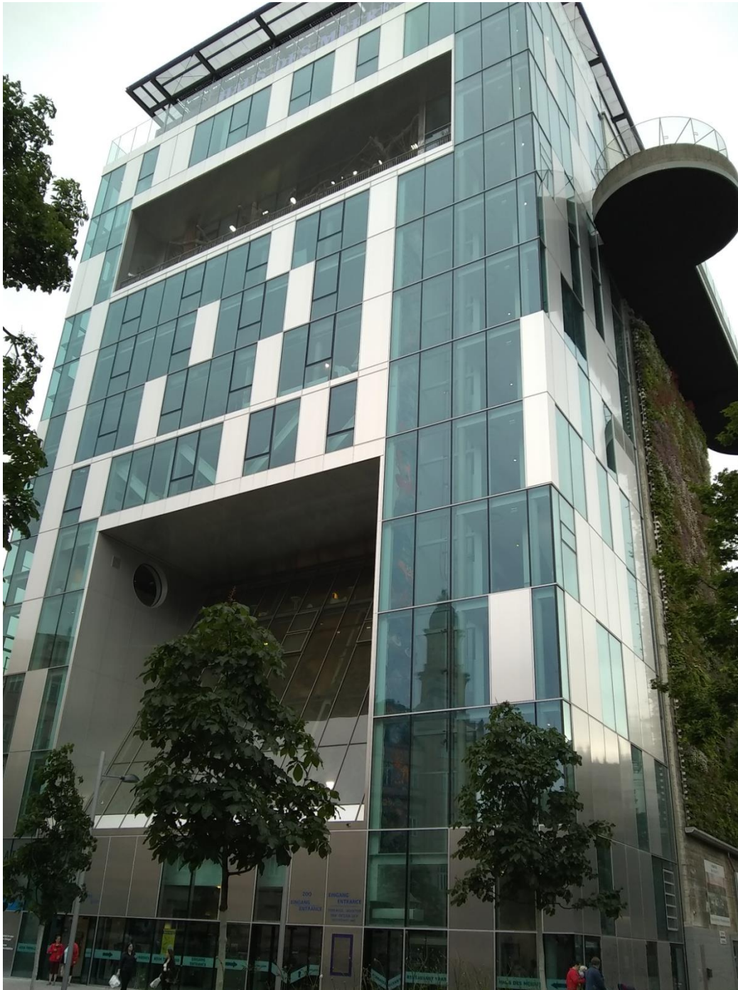
The Haus des Meeres building
